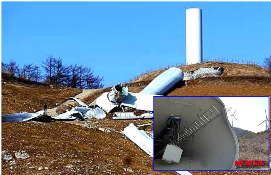
<그림 4-1> 강원도 태백 삼수동의 풍력발전기 타워의 접합부분 분리사고 현장 (우측하단: 사고 난 태백풍력 7호기의 절단면) (19)
